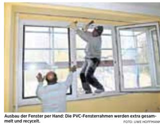
Ausbau der Fenster per Hand: Die PVC-Fensterrahmen werden extra gesammelt und recycelt. FOTO: UWE HOFFMANN
