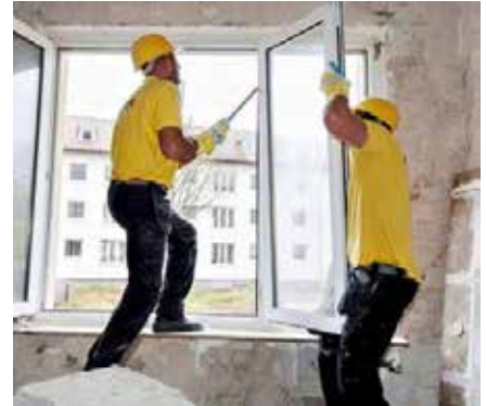
Alte Fenster sollen ersetzt werden. Aber wohin mit ihnen? Über das Rewindo-System lassen sich etwa alte Kunststoffrahmen recyceln.
