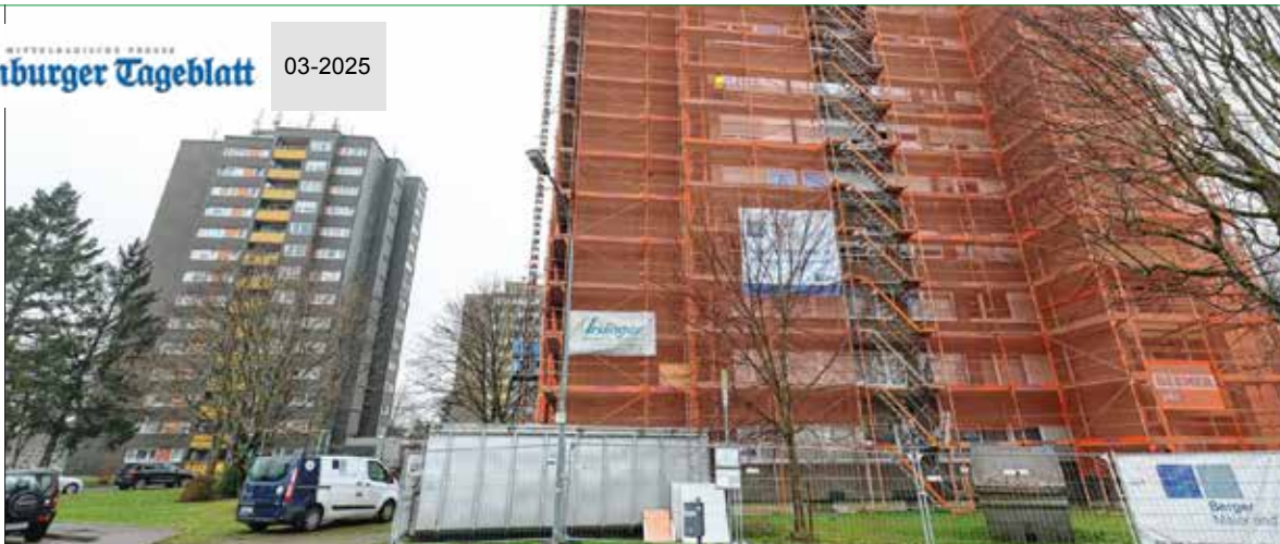
Die 1974 gebauten Hochhäuser der Gemibau am Stadtwald in Albersbösch werden aktuell für fünf Millionen Euro energetisch fitgemacht. Die ausgetauschten Fenster werden komplett recycelt. Fotos: Christoph Breithaupt
