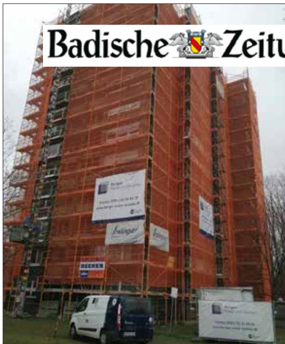
Eine der drei Hochhäuser in Albersbösch, bei denen die Gemibau derzeit die Altfenster recyceln und durch neue ersetzen lässt. FOTOS: WINFRIED KÖNINGER
